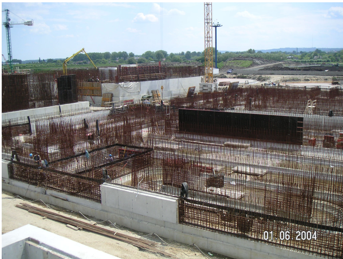
Fot. 1. Płyty fundamentowe, ściany i kierownice reaktorów oczyszczalni ścieków „Płaszów II” w Krakowie z pompowalnego betonu C25/30 na cemencie hutniczym i naturalnym żwirze o uziarnieniu do 32mm
