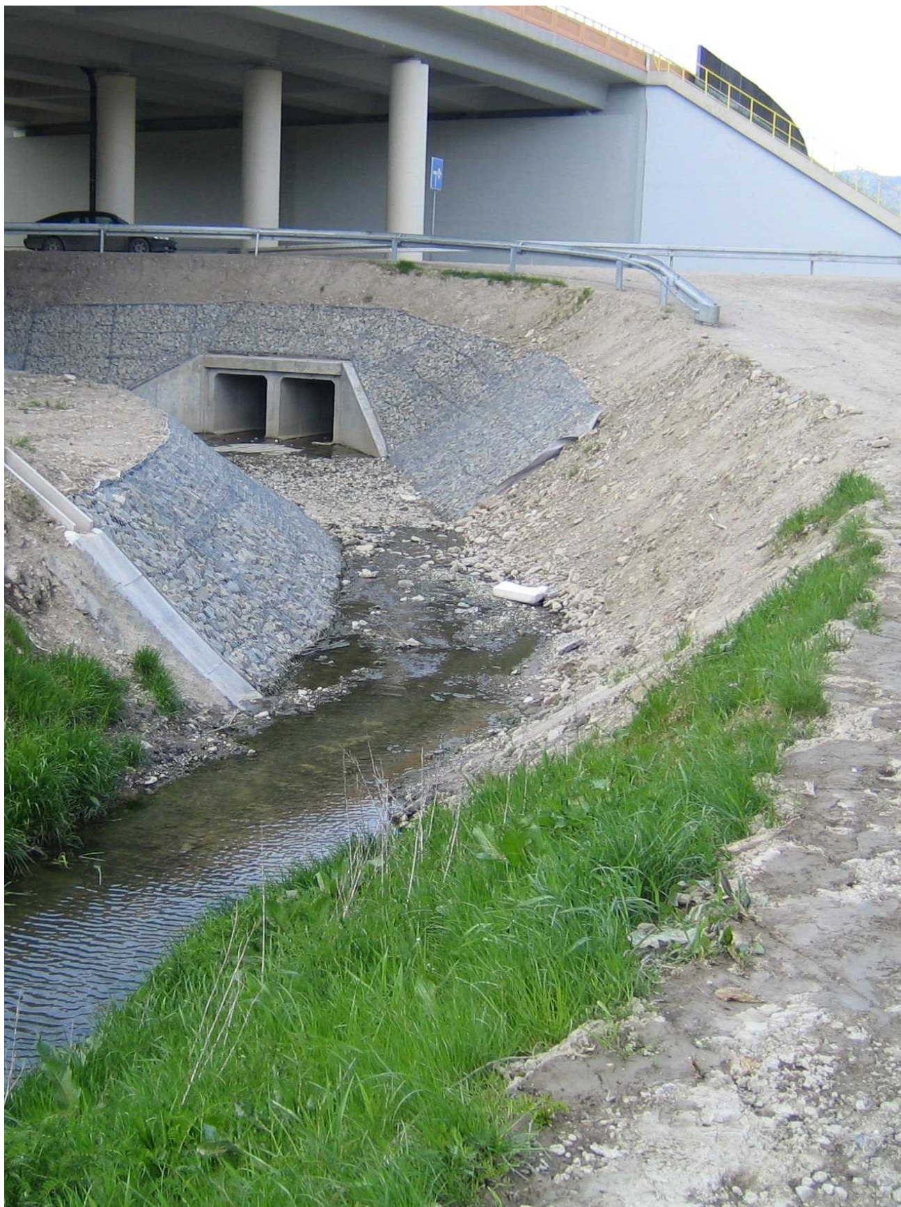
Rys. 1. Zanik przepływu dopływu Raby w osiatkowanym dnie rowu przydrożnego, do którego dopływ ten został skierowany bez wyraźnej potrzeby
