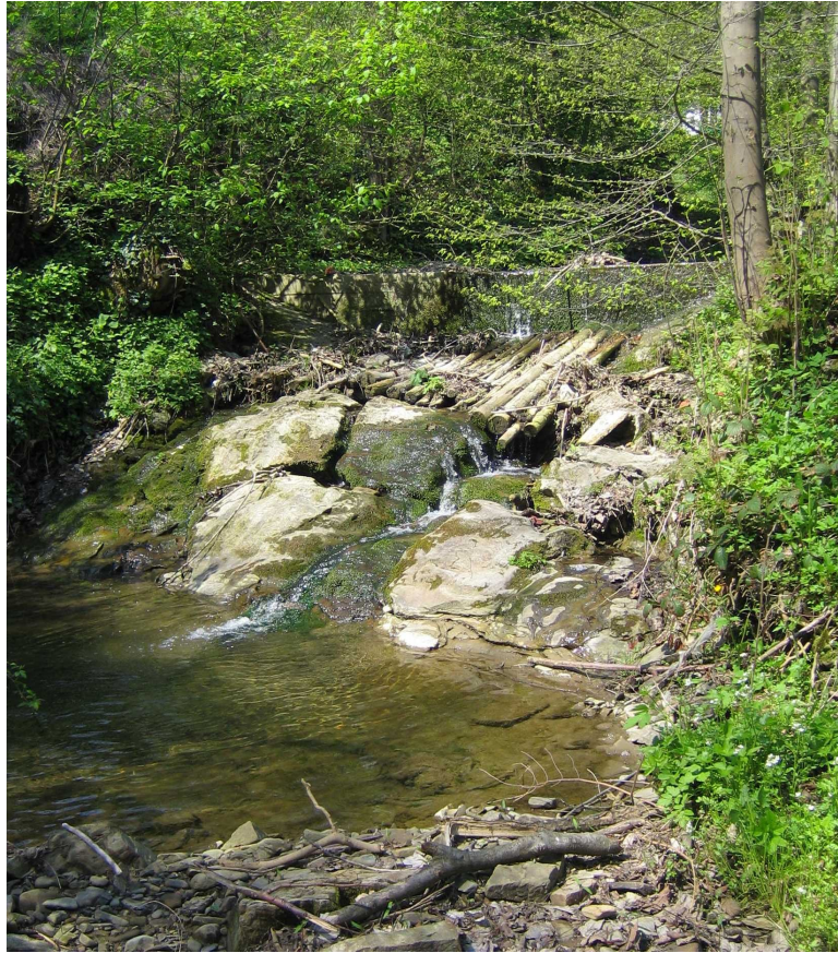
Betonowy próg i rampa drewniana na skalnym wodospadzie potoku Miłogoszcz
