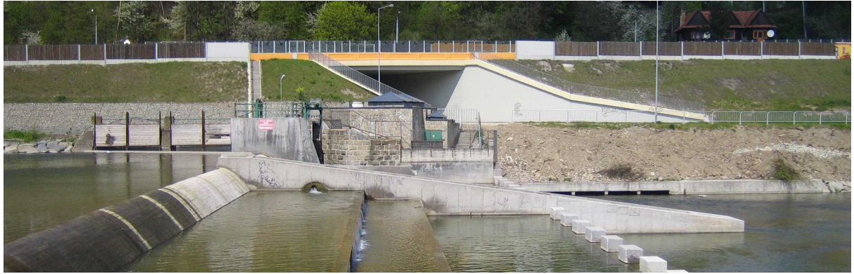
Jaz elektrowni w Myślenicach – widoczna przepławka i otwór ewakuacyjny z płytkiego basenu, w którym uprzednio były uwiecznione łososiowate, z łatwością pokonujące pośrednie stopnie i nie mogące pokonać ostatniego
