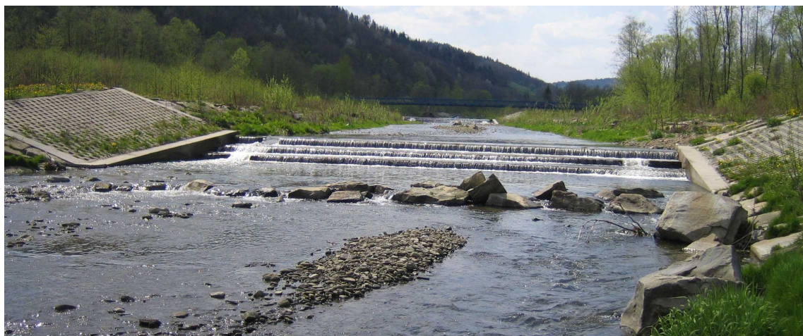
Betonowe stopnie wykonane jako seria z pochylniami betonowymi, nurt meandrujący
