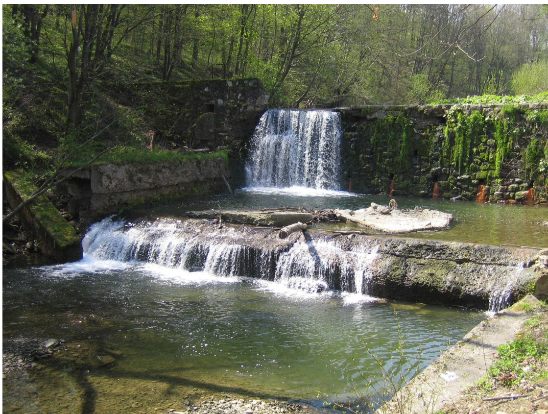
Dawna zapora elektrowni – dziś służy jako zapora przeciwrumowiskowa i całkowicie odcina jeden z najpiękniejszych dopływów Raby, potok Trzebuńka
