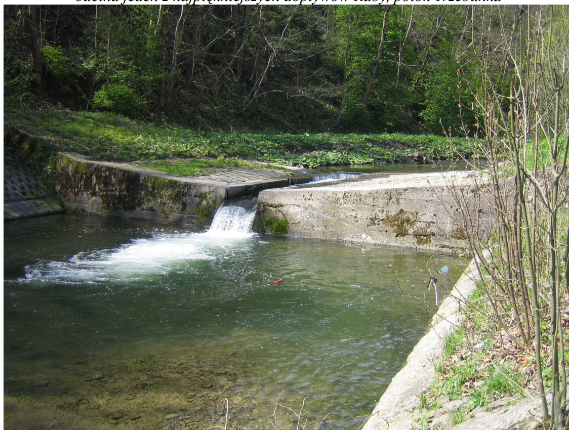
Stopień wodowskazu w Stróży na Trzebuńce, bardzo trudny do pokonania ze względu na długą i płytką betonową rynnę
