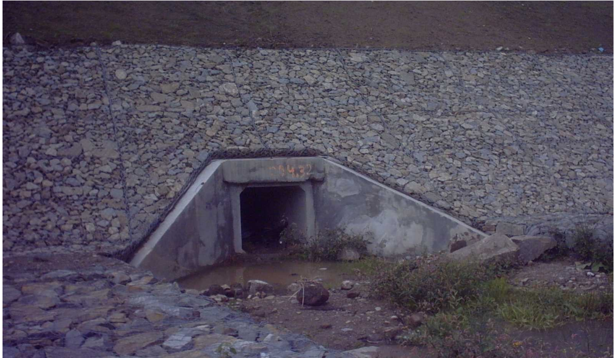
7. Gabiony zastosowane właściwie – umocnienie skarp nasypu drogowego dla cieku okresowego.
