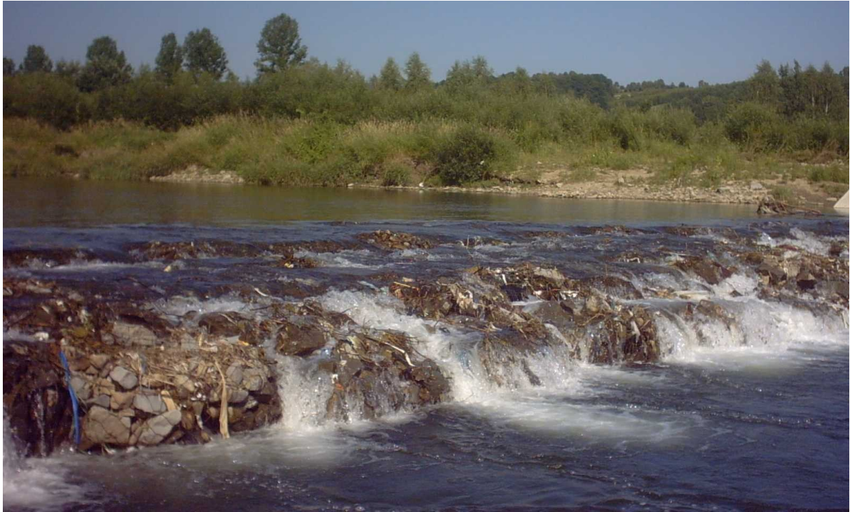
5. Całkowite odcięcie drogi powrotnej dla tarlaków łososi przez gabionowy próg na Rabie – przykład bezmyślności i braku poczucia jakiegokolwiek estetyki.
