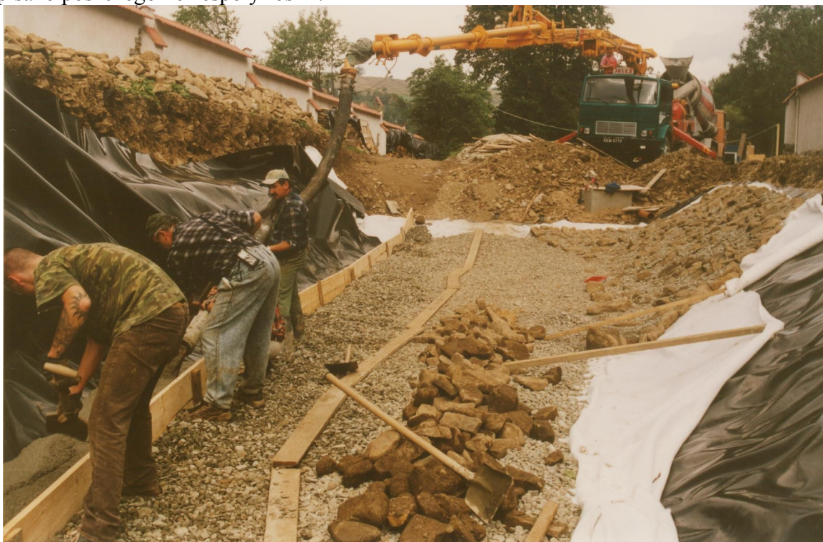
8. Budowa stawu rybnego: betonowanie fundamentu pod mur oporowy, widoczny balast żwirowy na dnie i z głazów na skarpie (dla obciążenia geomembrany osłoniętej geowłókniną)
