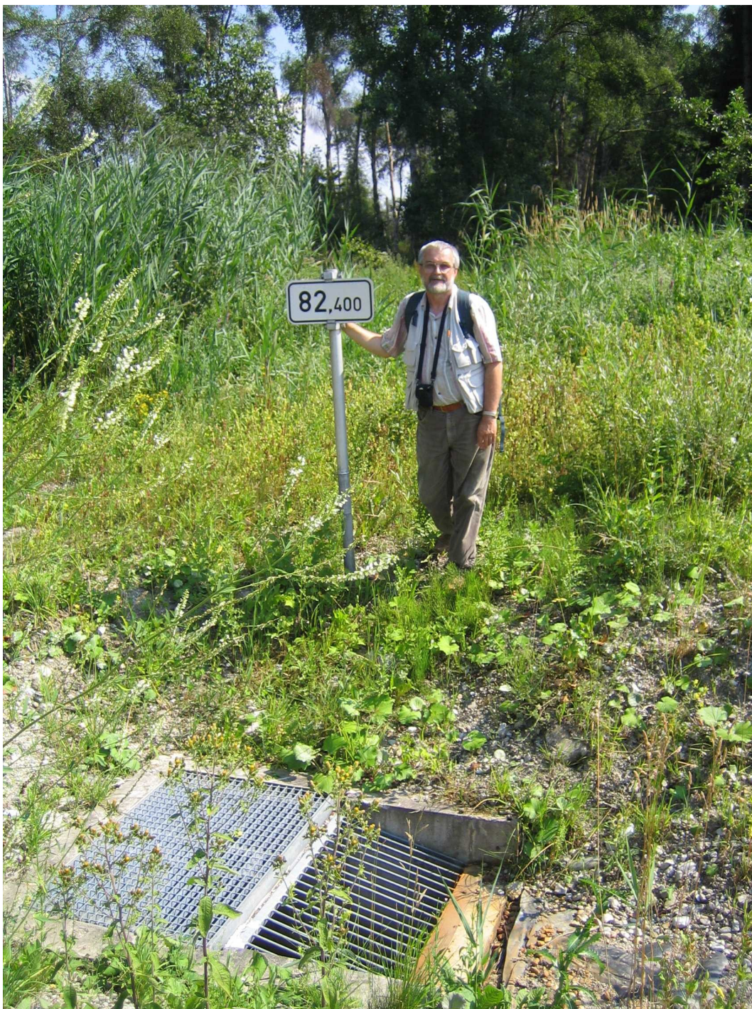
11. Przelew awaryjny ze zbiornika retencyjnego zespolony z komorą operacyjną, zaledwie widoczne przy naturalnie wyglądającym zbiorniku w km 82+400 autostrady Monachium – Salzburg
