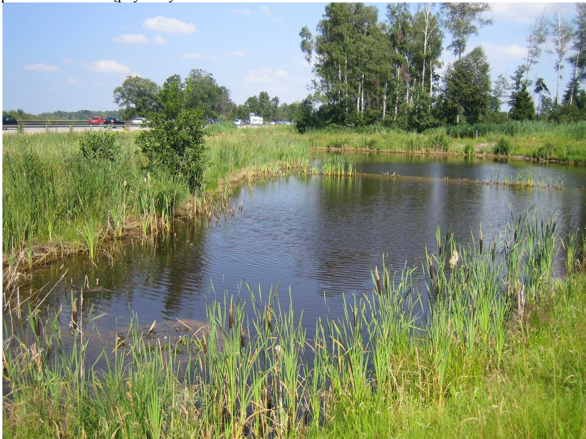
9. Zbiornik retencyjno-infiltracyjny przy autostradzie Monachium – Salzburg
