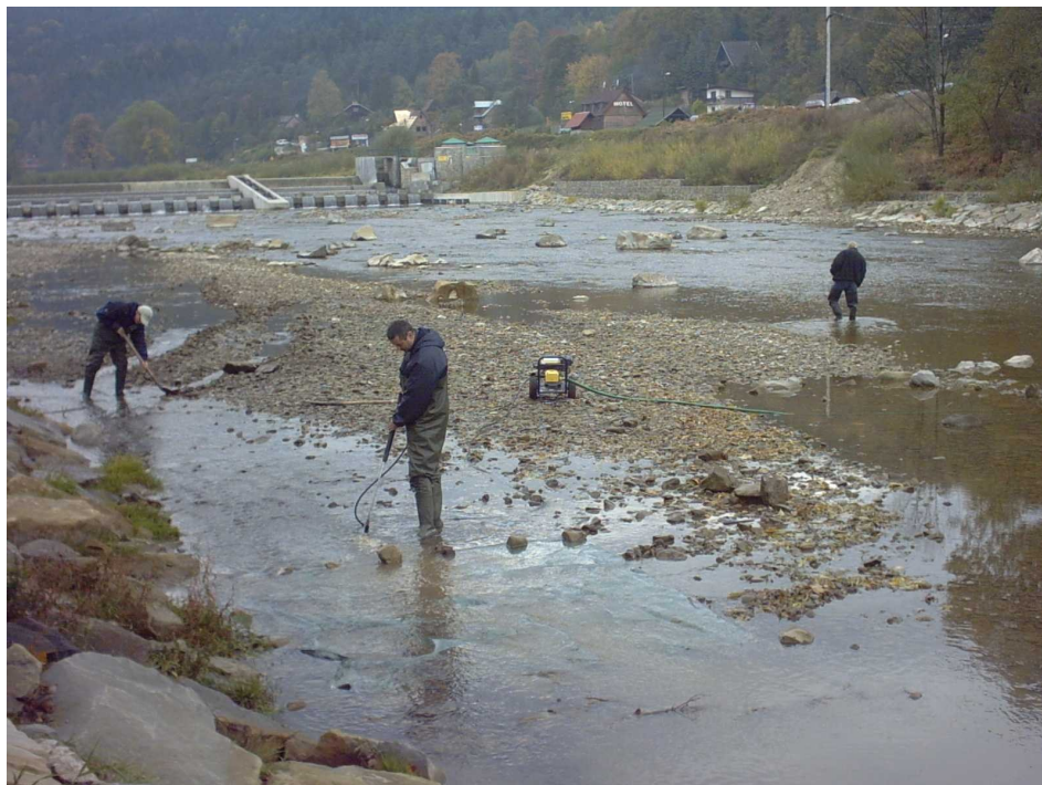
Rysunek 6. Lokalizacja miejsca tarliska: poniżej jazu z przepławką, w okolicy dobrych ukryć dla pstrągów i na ujściu dopływu doprowadzającego stosunkowo ciepłą, źródlaną wodę w zimie. Oczyszczenie żwiru z około 20% piasku do 10% zwiększy czterokrotnie przeżywalność ewentualnie złożonej tu ikry. Jeśli oczyszczony żwir nie będzie użyty jako tarlisko, to można go wykorzystać jako miejsce inkubacji zaoczkowanej ikry z wylęgarni.
