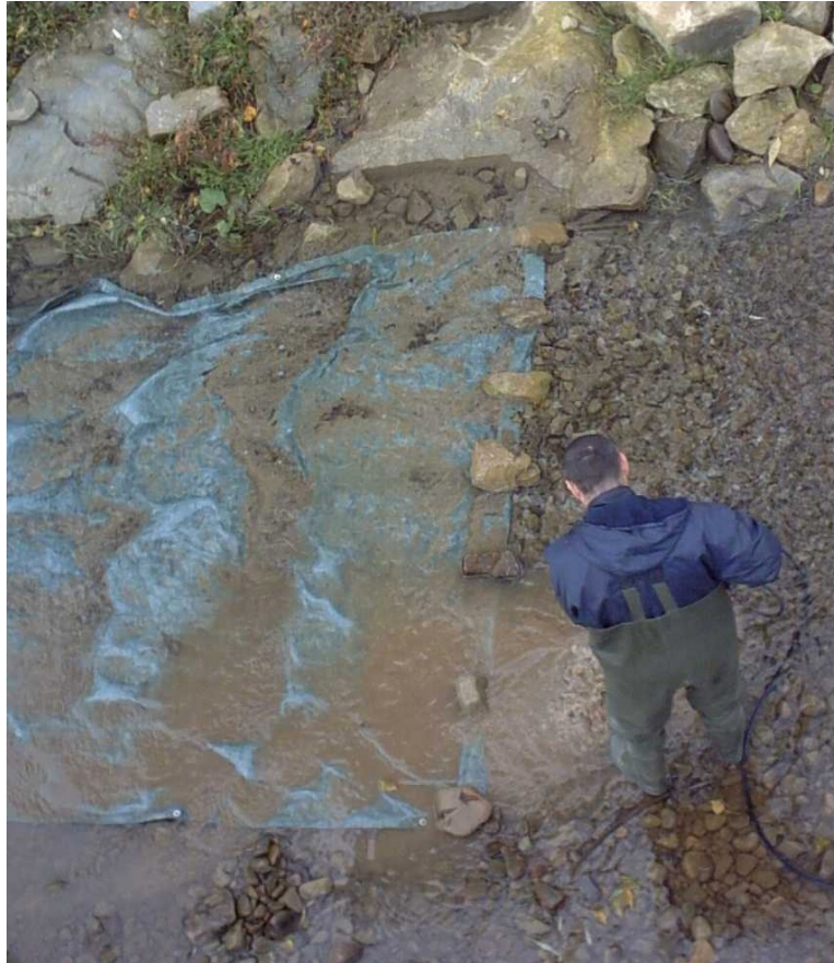
Rysunek 5. Czyszczenie żwiru tarliska ciśnieniowym urządzeniem do mycia, pasami szerokości około 1m, sekwencyjnie, pod prąd wody. Oczyszczone miejsca osłania się plandekami
