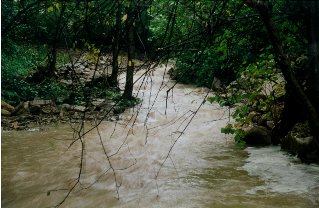
10. Górski potok przy napelnieniu wodą 50%, a po lewej osadnik – opóźniacz wód opadowych z rowów ulicy Górnej w Myślenicach (około 1,5 km długości). Konstrukcja: opaska z narzutu kamienno-żwirowego około 0,60 do 0,80 m wysokości, w miejscowym żwirowym poszerzeniu doliny, formująca potrójne zagłębienie terenu, około 40x5 m.
